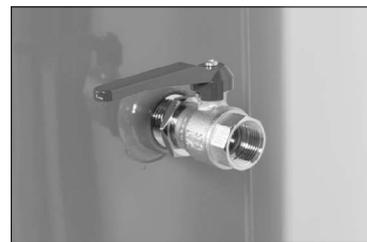
Attention vérifier le sens de fermeture du robinet, vous serez peut être amené à inverser le sens de la poignée : avec une petite clé plate dévisser l'écrou sur la tête du robinet, inverser la poignée puis remettre l'écrou (bien serrer).
