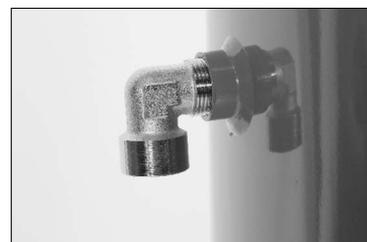
Sur la sortie latérale basse droite mettre l'ensemble réduction 1 M-3/4 F et robinet 3/4 M/F (étancher la liaison avec du ruban téflon fourni).
