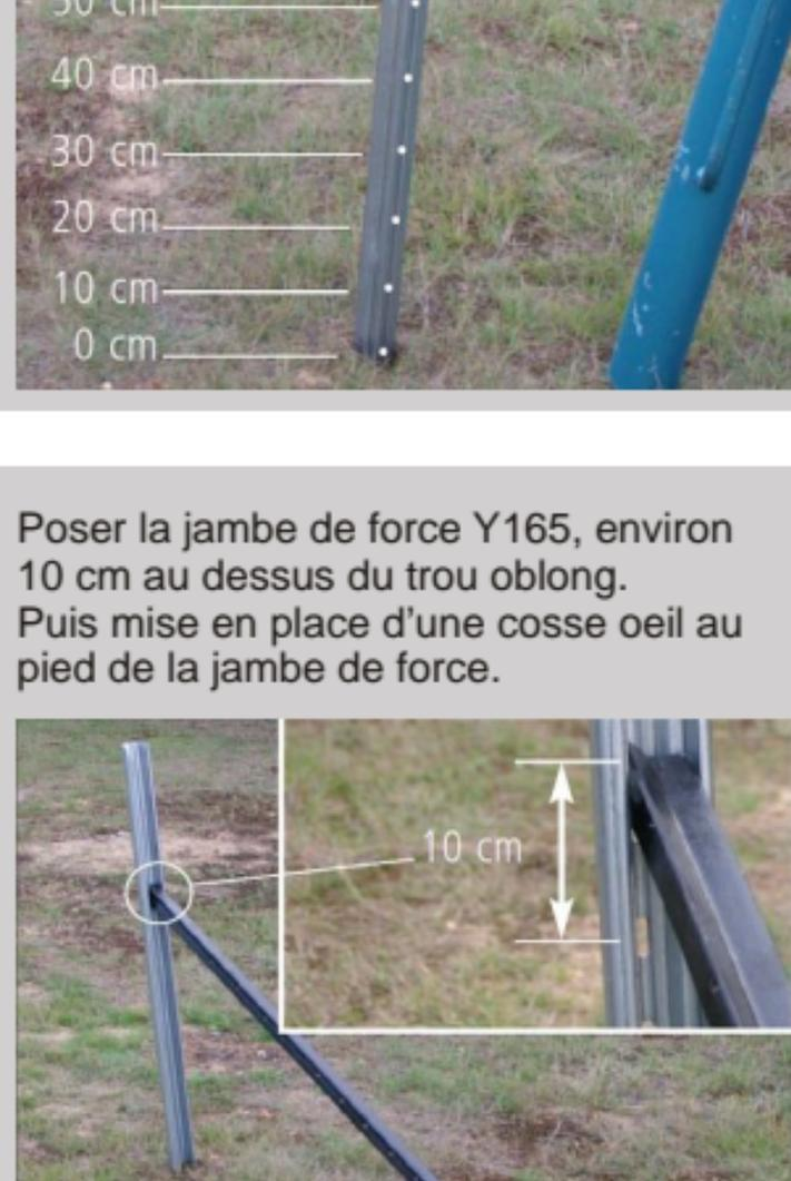
Poser la jambe de force Y165, environ 10 cm au dessus du trou oblong. Puis mise en place d'une cosse oeil au pied de la jambe de force.
