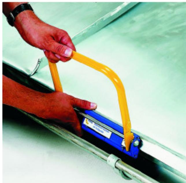
Permet le façonnage rapide et net du larmier au niveau de la bande d'égout, des lucarnes et de travaux similaires.
