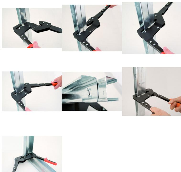
Spécial sertissage montants dos à dos (recommandé pour une hauteur de plafond supérieure à 2,50 m).
