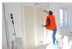
Permet le lissage des enduits, bandes à joints, plâtre.
