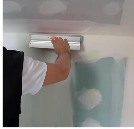
Perche réglable pour les hauteurs de mur et les plafonds (faire la passe au plafond en reculant)
