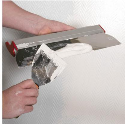
**Idéal pour une finition impeccable des bandes de plâtre (lames de 0,3mm)**
