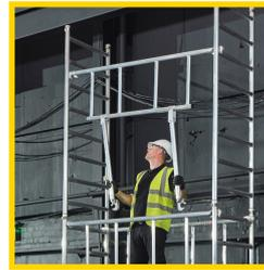
CHARGE MAXI ADMISSIBLE SUR UN PLANCHER : 150 KG
