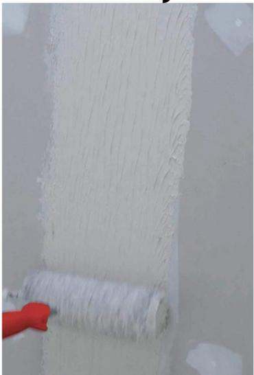
**Rouleau spécialement conçu pour appliquer rapidement et efficacement l'enduit sur bandes à joint ou grandes surfaces (murs, plafonds).**
