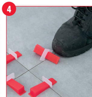
Après séchage, par un simple coup de pied, casser la partie haute de la bride+ cale.
