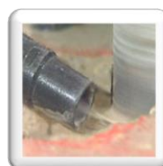
Aspiration des boues de chantier
