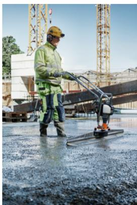
La plaque de fond rigide dispose d'un profil en forme de V qui entraîne l'excès de béton vers l'arrière et remplit toute trace de pas que vous auriez laissée.
