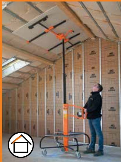
POSE SOUS RAMPANTS
