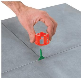
Le tête peut ensuite être légèrement pressée sur le carreau pour un nivelage parfait (un tour suffit).
