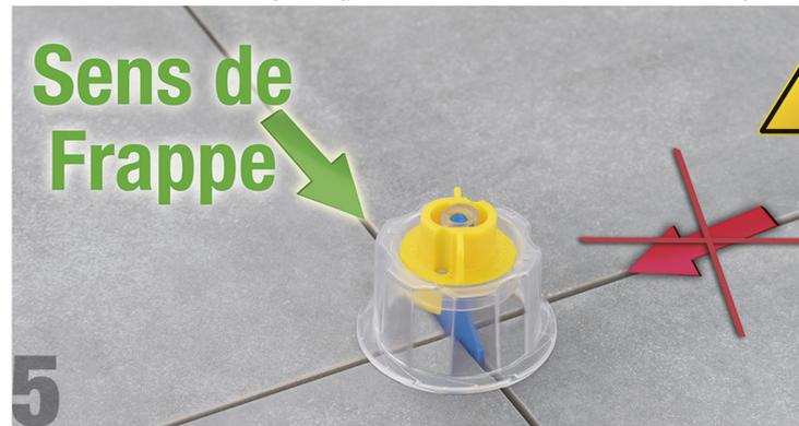
! Pour les croisillons en croix, la frappe doit être faite dans l'axe le plus étroit de la tige et non sur le côté large de la base de la tige.
