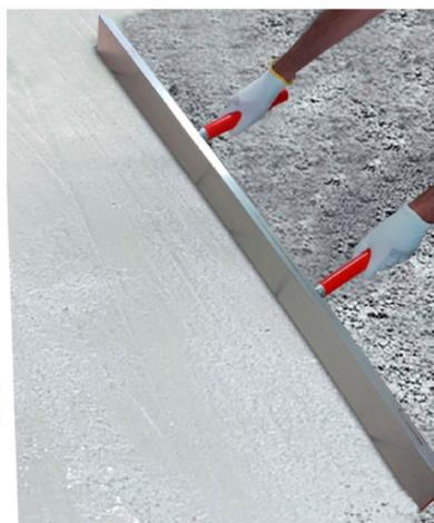
Pour tirer une dalle béton et régler le niveau avec un confort optimal. 2 longues poignées ergonomiques permettent de mieux manipuler la règle.
